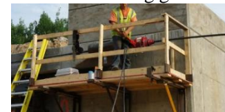
(d) Repositioning a jack after completing a pull
